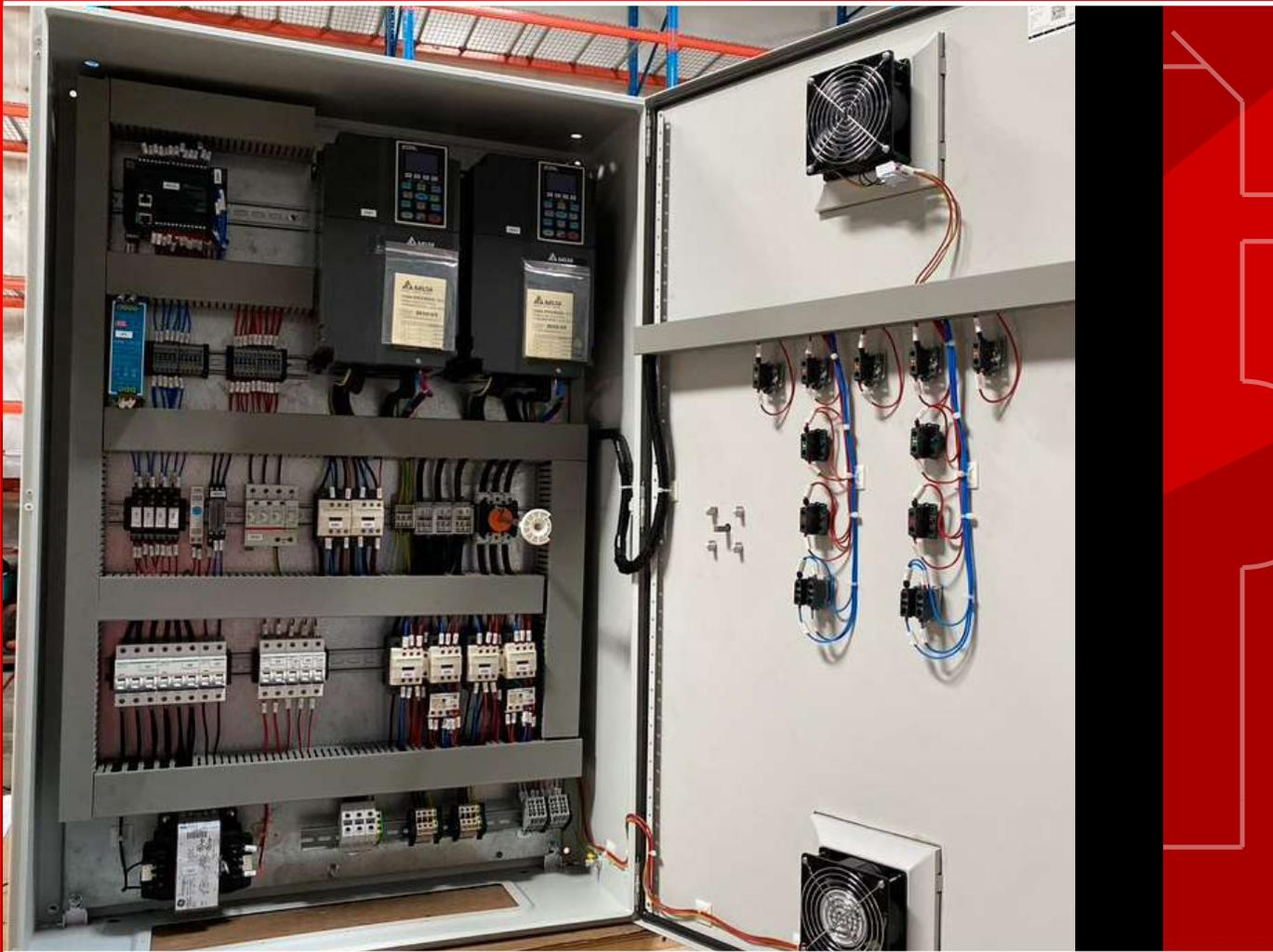
Automatización y control de sistema en torre de enfriamientos con VDF Delta y PLC Modicon M221 Schneider.
