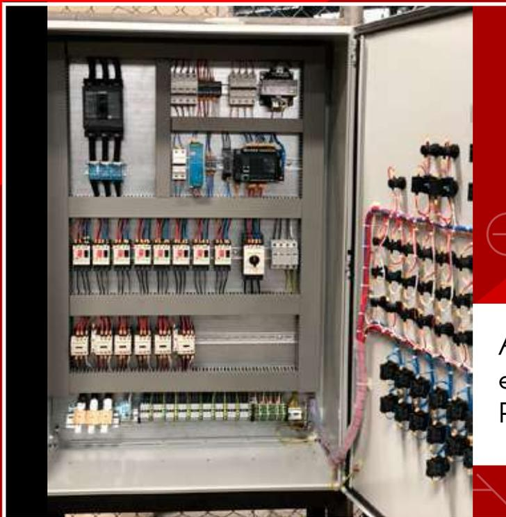
Automatización para planta de empaquetadora de cementos, con PLC Modicon M221 Schneider.
